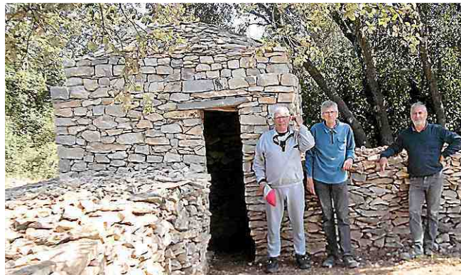
Une équipe qui a reconstruit les capitelles Milhaudoises. ARCHIVES
