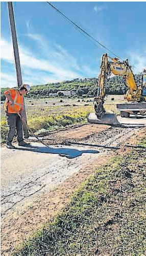
Les travaux sont terminés sur les chemins de l'Arnave et Cabrimont.
