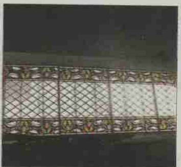
■ Les nouvelles fenêtres de la chapelle.
